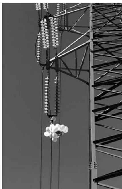
Необходимость применения защитных экранов ЭЗШ обуславливается тем, что при прохождении ВЛ в черте городов отмечаются случаи закорачивания линий при перемещении связок шаров по проводу в сторону изолирующих подвесок под воздействием ветра с возможностью их шунтирования на металлоконструкции опоры, что приводит к перекрытию подвесок и отключению ВЛ.
